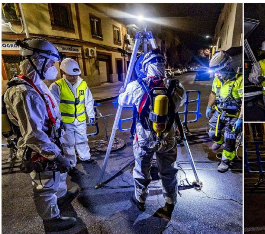
Imágenes de las labores de análisis y mapeo del colector general que realiza el Ayuntamiento con Aquona y la empresa Hovering Solutions. / 1
