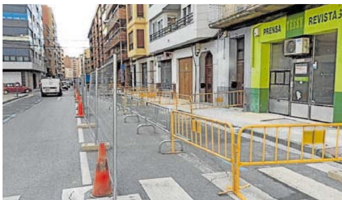
Tramo de Bebricio en la que se renueva la red abastecimiento. A. C.
