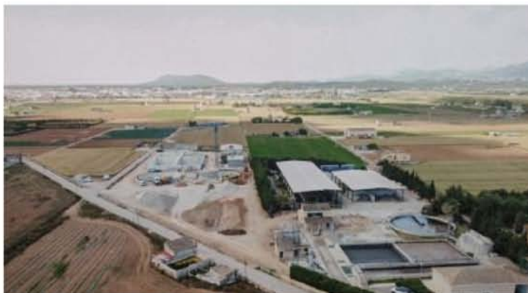
Obras de ampliación de la EDAR de Sa Pobla, en Mallorca.
