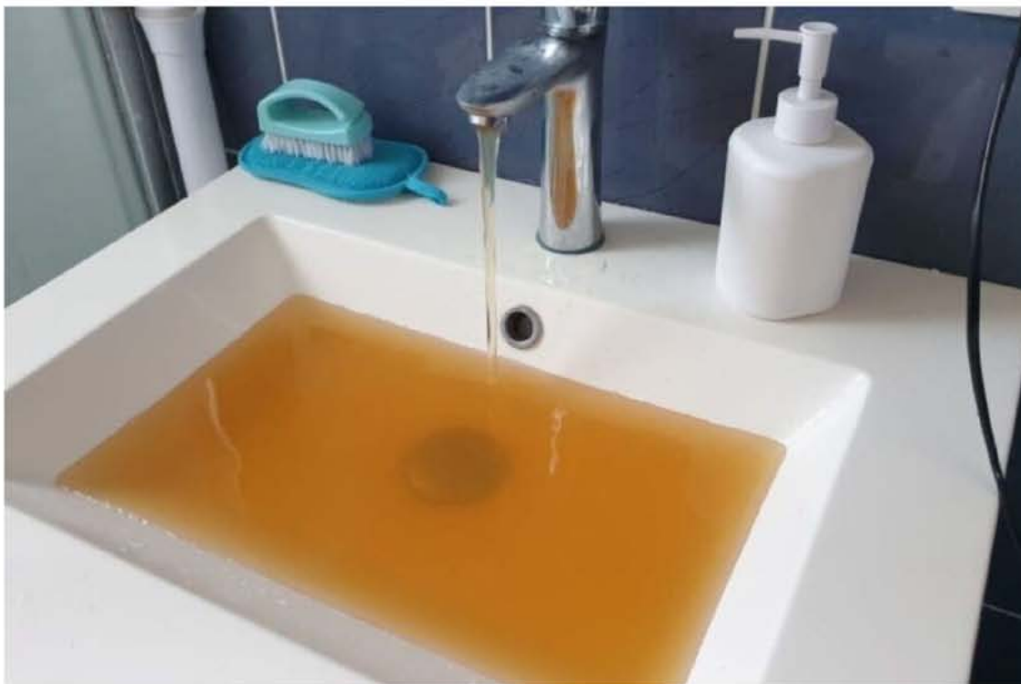
Leau est parfois marron chez les habitants de Montreuil-l'Argillé. Cela est dû au fer contenu dans les tuyaux. ©Photo transmise par un habitant de Montreuil-l'Argillé
