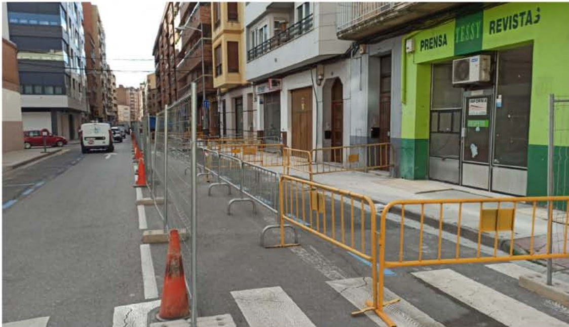
Los trabajos afectan al carril derecho de circulación rodada en un tramo de unos 100 metros
